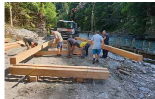
Foto: Zuschnitt der vielen Einzelteile
