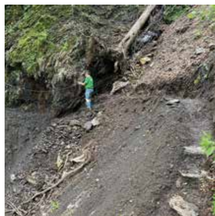
Foto: Einspannen eines Stahlseiles
